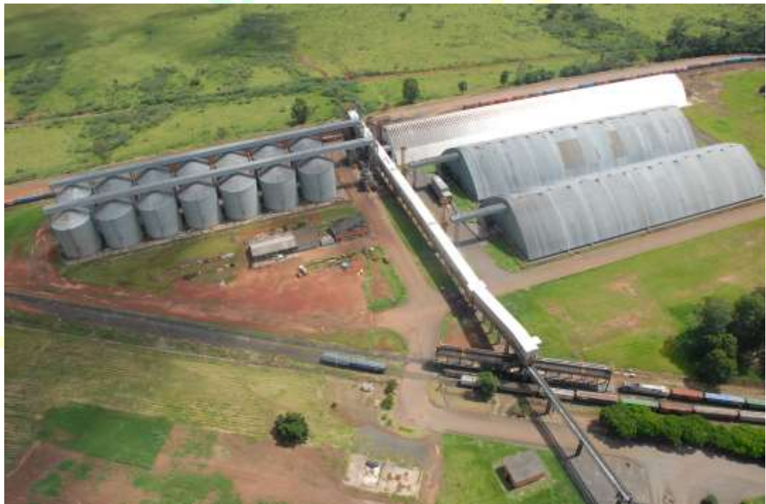
Foto: Terminal Graneleiro de Sumaré.
